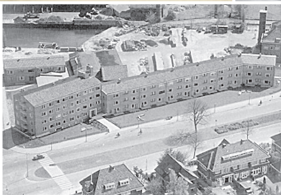
■ Overzichtsfoto bouw van de olijftak 1954
