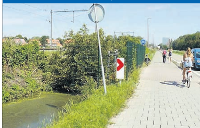
Overwoekerde brug met hek anno 2015.
