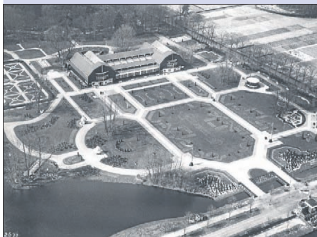
Luchtfoto terrein Flora 1925 (detail).
