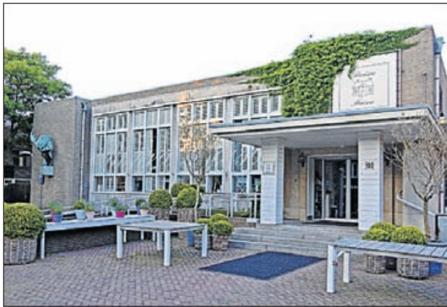
Het voormalige postkantoor.
