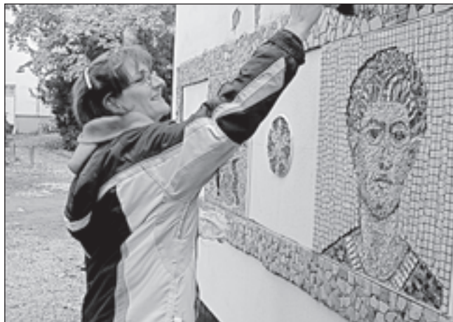
De laatste hand wordt gelegd aan het mozaïek.
