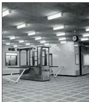
De hal van het net gebouwde viaductstation Heemstede-Aerdenhout in 1958: loketten en het huisje waar de kaartjes gecontroleerd werden.
