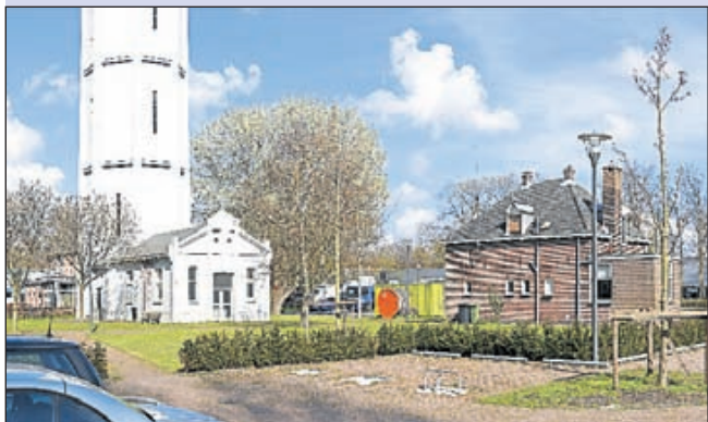
Monteurswoning (foto's: Theo Out).
