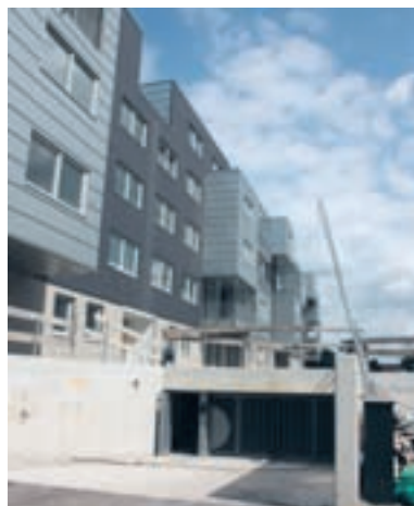
'Schip', het gebouw dat direct aan de vaart ligt, nadert zijn voltooiing. Onder het gebouw komt een parkeergarage.
