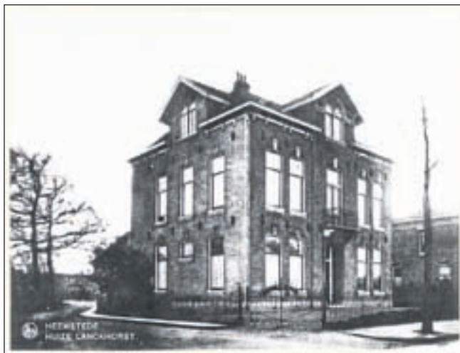
Huize Lanckhorst op de hoek van de Lanckhorstlaan en Bronsteeweg maakte later plaats voor het betonnen bankgebouw van de Amrobank, later ABN-Amro. (Afbeelding: Noord-Hollands Archief)
