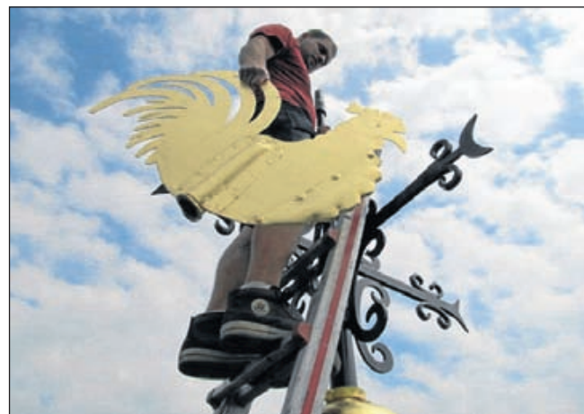
De toren van De Oude Kerk heeft vele weken voor een grondige renovatie in de steigers gestaan. Op 1 juli is de toren weer in volle glorie te bewonderen, inclusief een nieuw vergulde haan!
