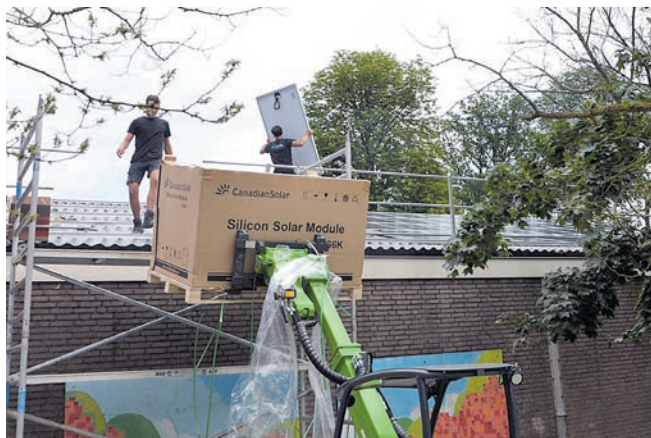
Heemstede in 2030. Het dak was problematisch, voor 'leken' ziet het eruit als golfplaten, voor vaklui sandwichpanelen, waar je niet zomaar zonnepanelen op kunt plaatsen. Een van de weinige bedrijven die dat kunnen is Enegieplussdak uit Lunteren en zij plaatsen maandag de panelen op het
