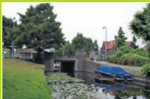
De Glipperbrug met het schakelstation.
