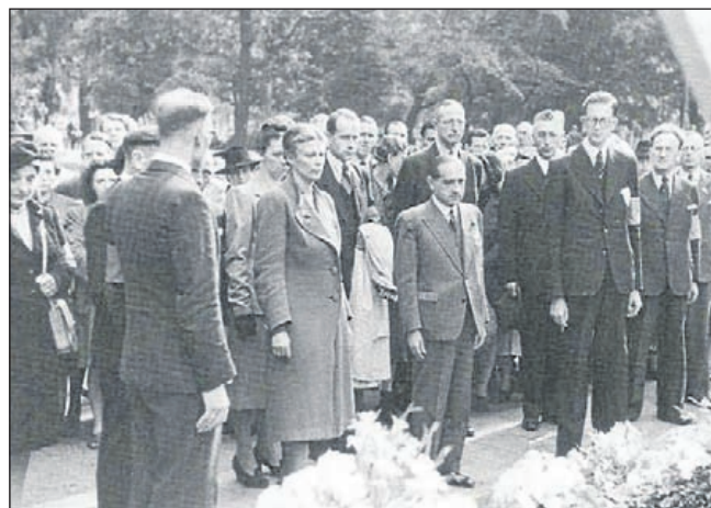
De fusillade op het Weteringplantsoen heeft Jacoba van Tongeren geestelijk en lichamelijk geknakt. Op deze foto staat zij vooraan bij een naoorlogse kranstegging.
