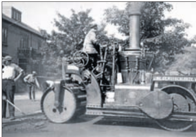
Mooie oude plaatjes zijn ieder nummer van HeerlijkHeden te vinden. Dit is een stoomwals van NV De Geruischloze Weg, de firma die o.a. de Heemsteedse Dreef aanlegde. (Foto uit album van 1935 voor Jan Schelling, directeur Openbare Werken Heemstede).
