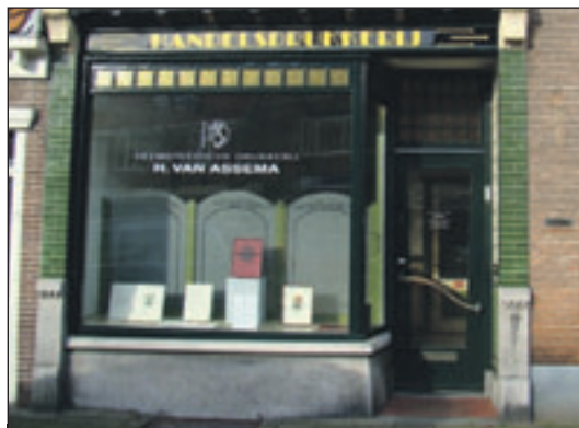
Raadhuisstraat 87 De winkelpui dateert uit 1912. Het opschrift: Heemstedse Drukkerij H. van Assema, verwijst naar de eigenaar van de drukkerij in 1942.
