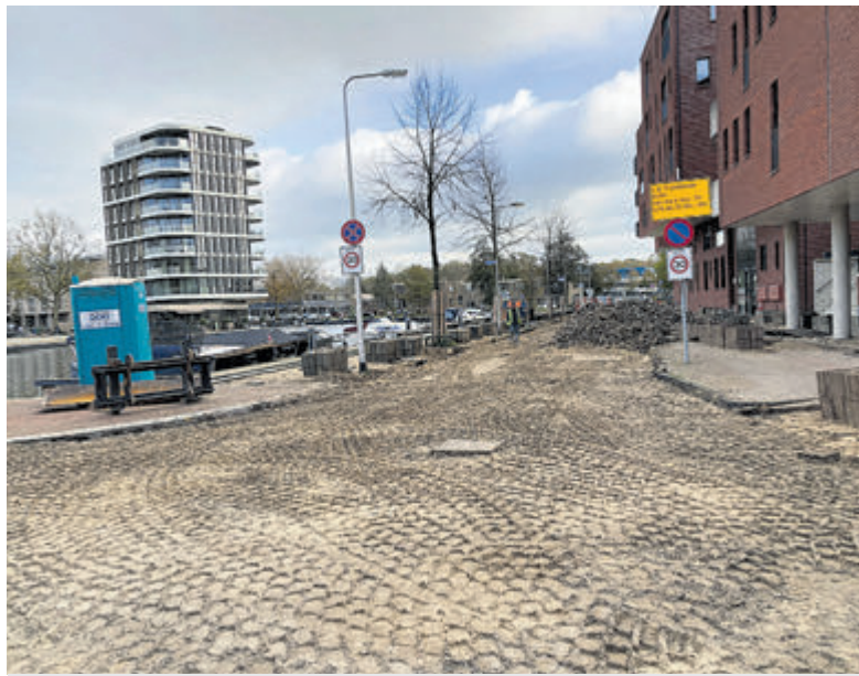
Werkzaamheden op de Van den Eijdekade. Foto: Harry Opheikens.
