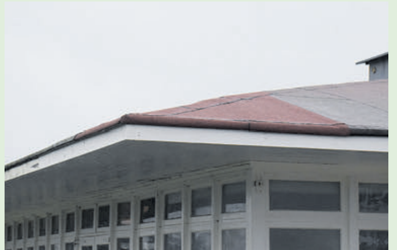
Het herstelde dak, foto van 21 oktober 2023.
