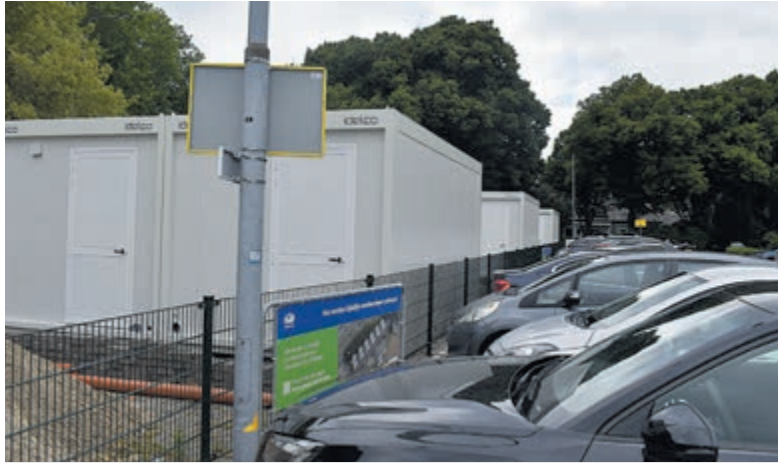
De containerwoningen. Foto: Eric van Westerloo.
