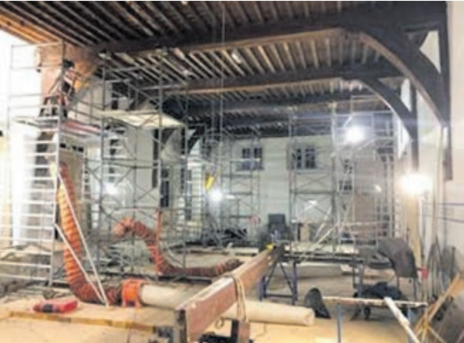
Zorgzaal (1463) gedurende restauratiewerkzaamheden (foto aangeleverd door het Dolhuys).
