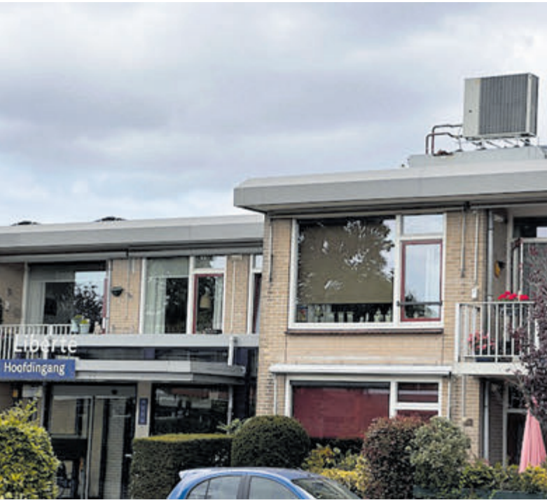
Met de plaatsing van de warmtepomp wordt de toegestane hoogte ver overschreden. Ook heeft Elan Wonen geen vergunning hiervoor aangevraagd. Foto: aangeleverd.
