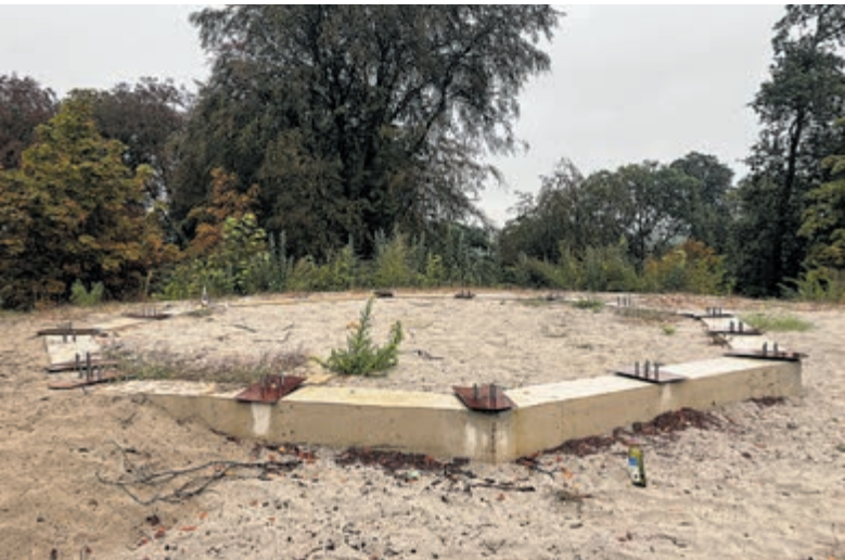
Het fundament ligt intussen al klaar voor ‘De Wandeling’.
