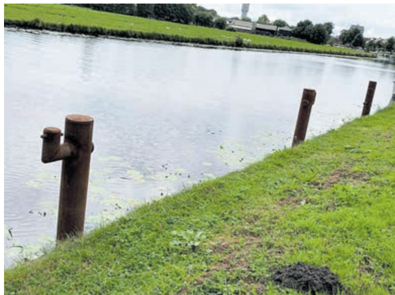
De geplaatste aanlegpalen.
