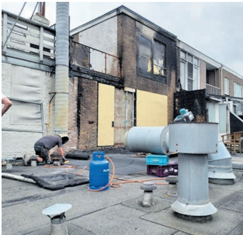
Herstelwerkzaamheden aan het dak van het restaurant. Foto: Cheval Blanc.
