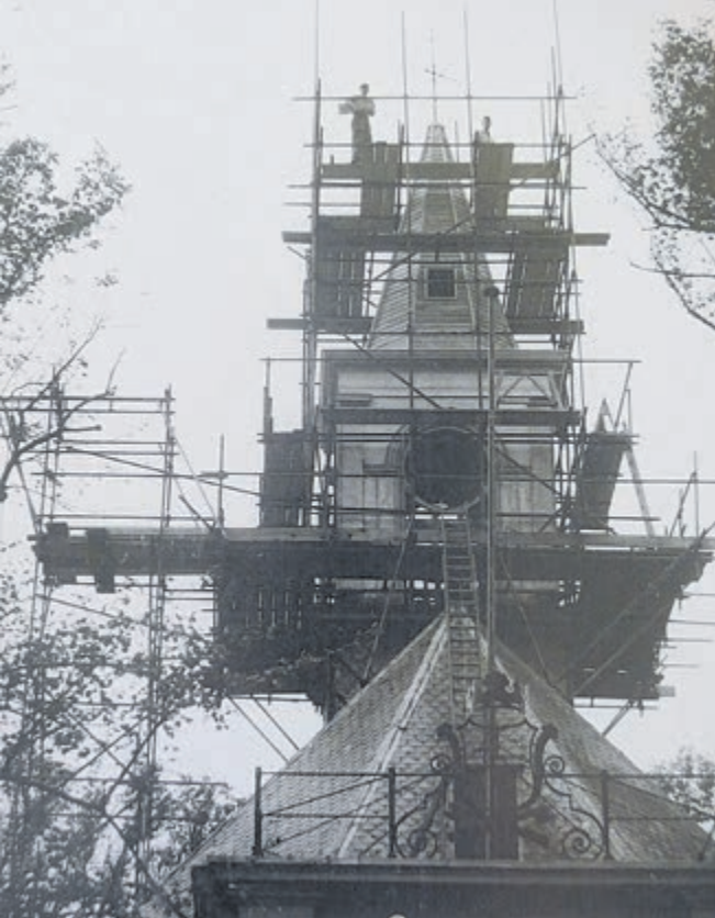
Plaatsing van de nieuwe torenspits van de Nederlands Hervormde Kerk in Bennebroek in 1956. De oude spits was het jaar daarvoor afgebrand.
