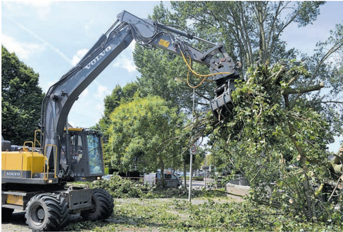
Opruimwerkzaamheden op Crayensterbrug. Foto: Bart Jonker.
