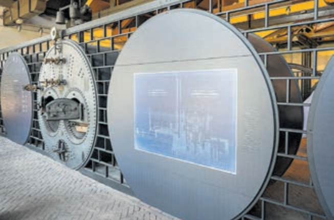
Het vernieuwde en volledige ketelfront in het Cruquius gemaal (foto Kees van der Veer).
