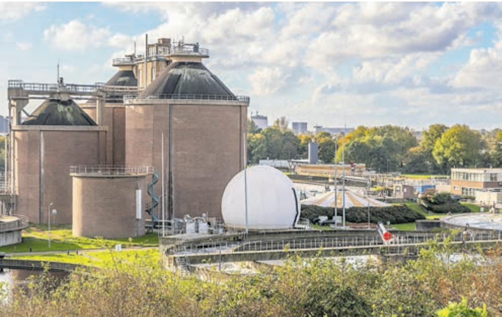
Afvalwaterzuivering Waarderpolder (aangeleverd door Rijnland).
