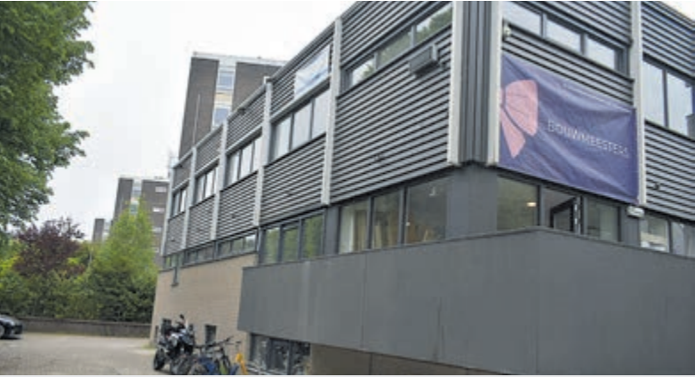
Het pand aan de Herenweg 55 is omgebouwd tot opvangplek voor Oekraïners. Foto: Eric van Westerloo.
