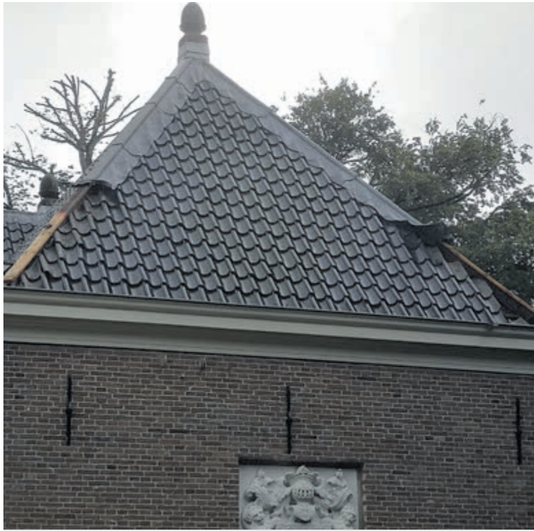
Op het dak van Elswout is duidelijk te zien waar het lood is weggenomen. Foto: aangeleverd door Staatsbosbeheer.
