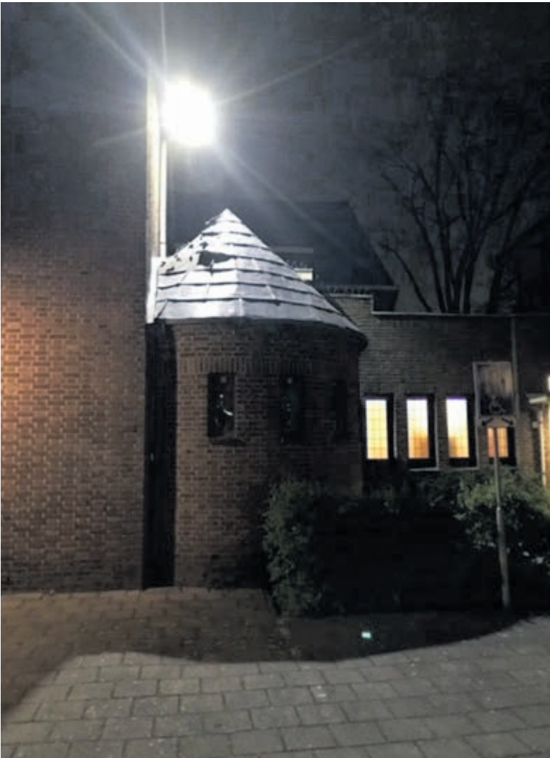
Het dak van de Calvariekapel. Foto: aangeleverd door OLV Hemelvaartkerk.
