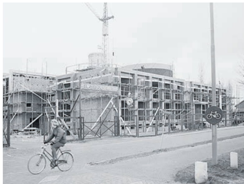
De kelder onder het voormalig politiebureau aan de Cruquiusweg 1 werd in 1966 geschikt gemaakt als noodbestuurspost voor de gemeente. De foto is van de bouw in 1965. Op de achtergrond is nog een gashouder zichtbaar van de gasfabriek. (Collectie Noord-Hollands Archief.)
