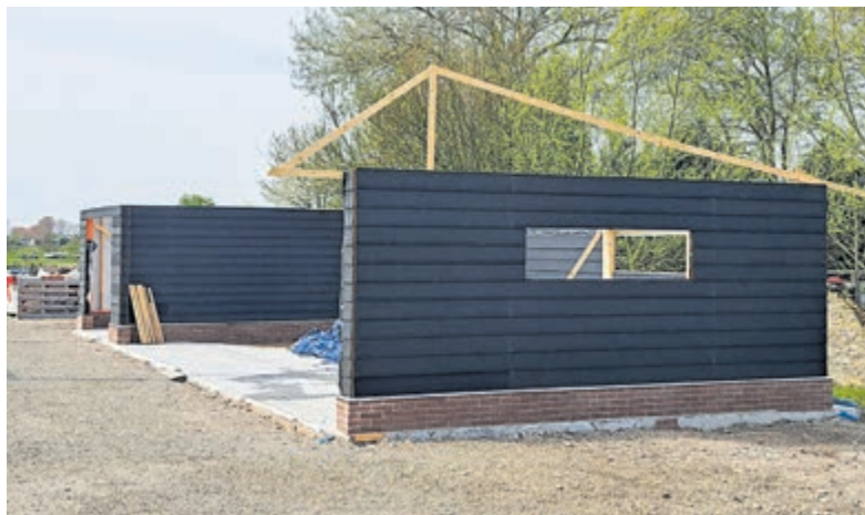
De bouw van de nieuwe keukenschuur voor de workshops. Foto aangeleverd.
