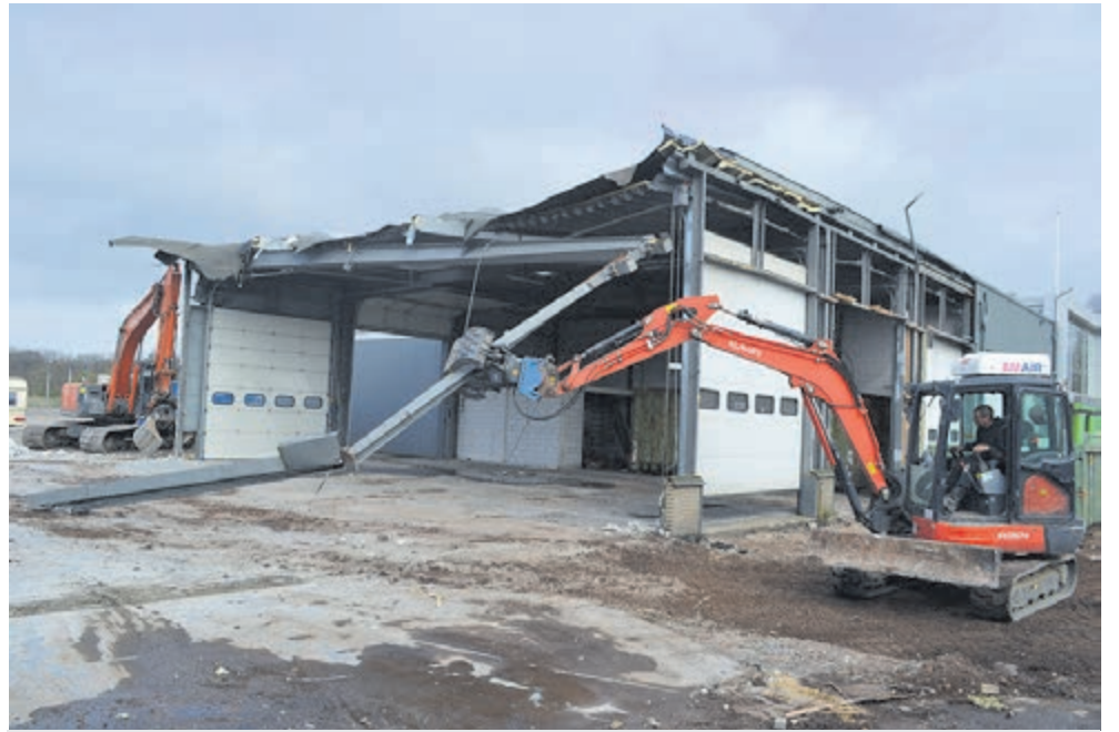
De sloop van de oude panden is begonnen. Fotograaf: Bart Jonker
