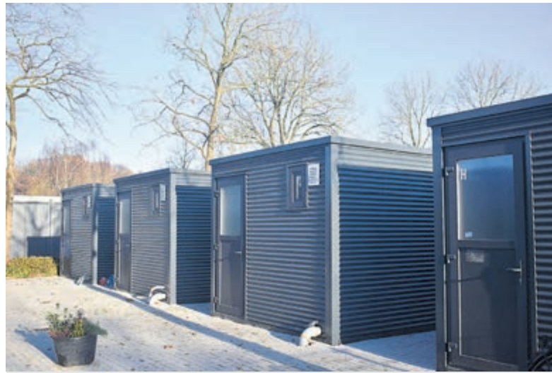
Containerwoningen Kohnstammlaan. Foto Eric van Westerloo
