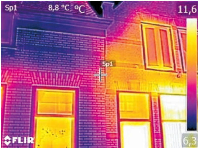
Warmtefoto. Foto: aangeleverd door HeemSteeds Duurzamer.
