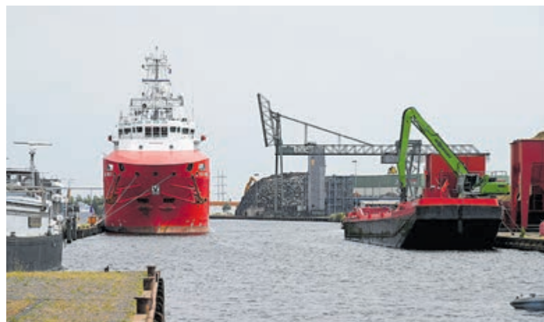
Noordzeekanaal. Foto: aangeleverd door Omgevingsdienst IJmond.
