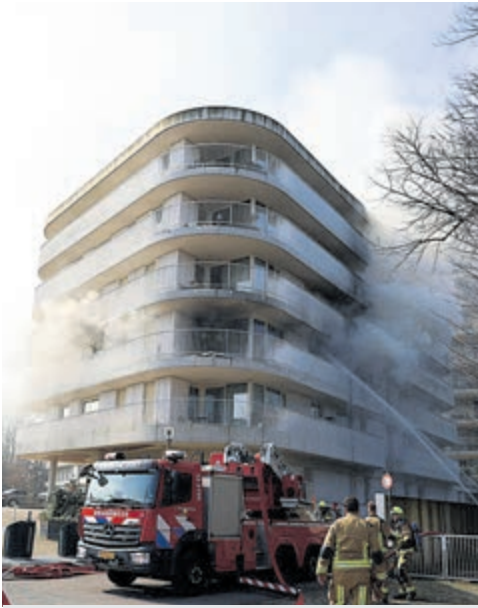
Brand in een van de wooncomplexen van Nieuw Overbos. Beeld: AS Media.
