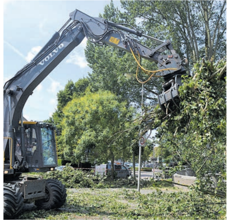
Opruimwerkzaamheden op Crayensterbrug. Foto: Bart Jonker.
