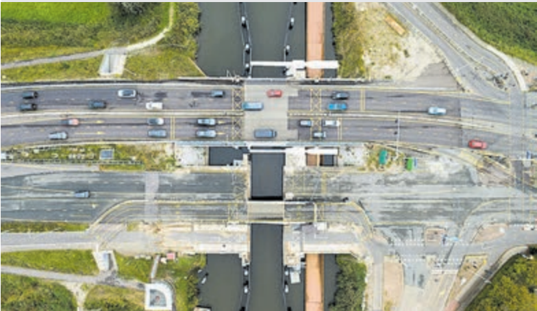
Luchtfoto van tot nu toe vernieuwde Cruquiusbrug. Foto aangeleverd door Provincie NH.
