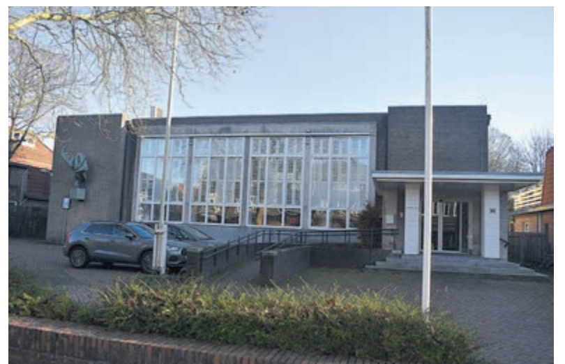
Voormalig postkantoor aan Binnenweg. Foto: Eric van Westerloo.
