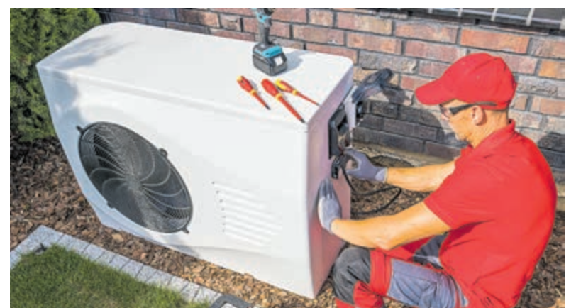
Warmtepomp die wordt geïnstalleerd. Foto: Bigstock.
