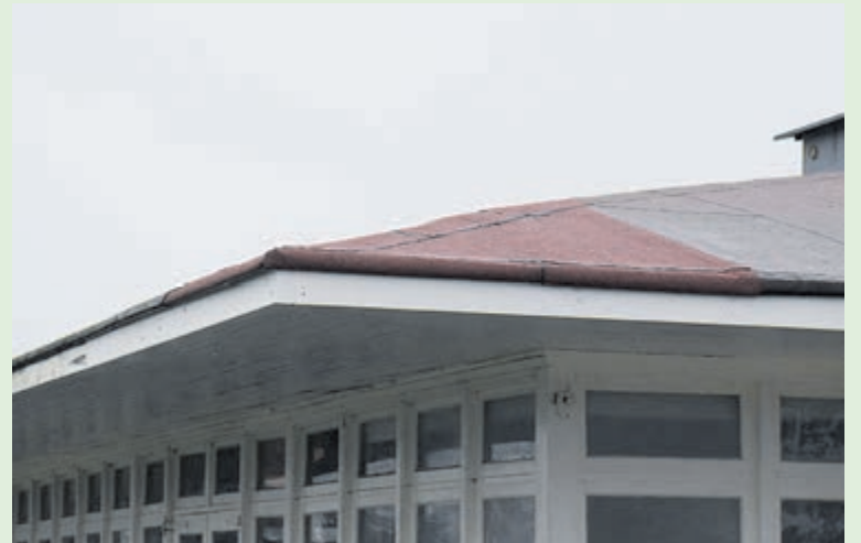
Het herstelde dak, foto van 21 oktober 2023.
