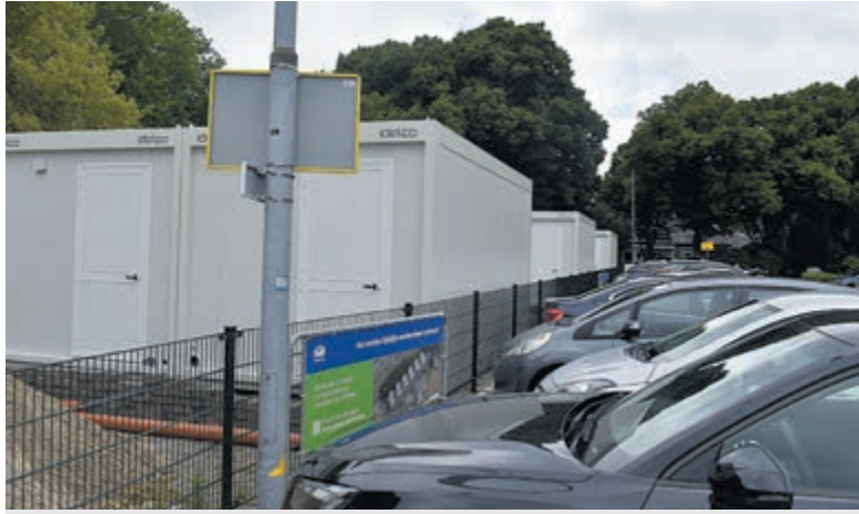
De containerwoningen. Foto: Eric van Westerloo.
