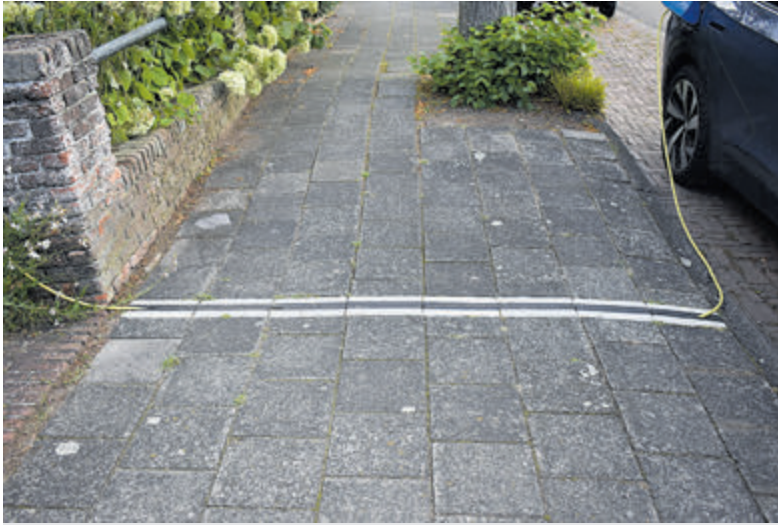
Kabelgoot. Foto: Eric van Westerloo.
