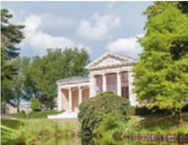
Imposante bouwwerken (foto: Gilde Haarlem)
