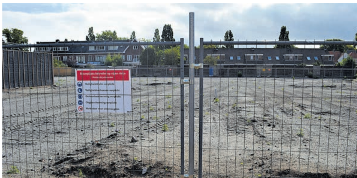
Het bouwterrein waar de nieuwe Vomar moet komen. Foto: Eric van Westerloo.
