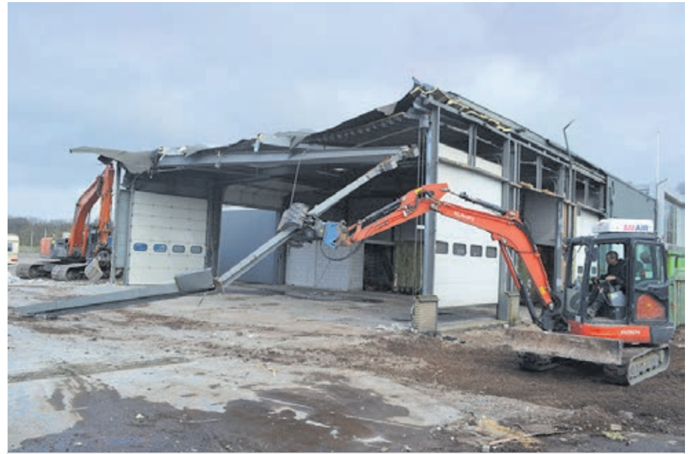
De sloop van de oude panden is begonnen. Fotograaf: Bart Jonker
