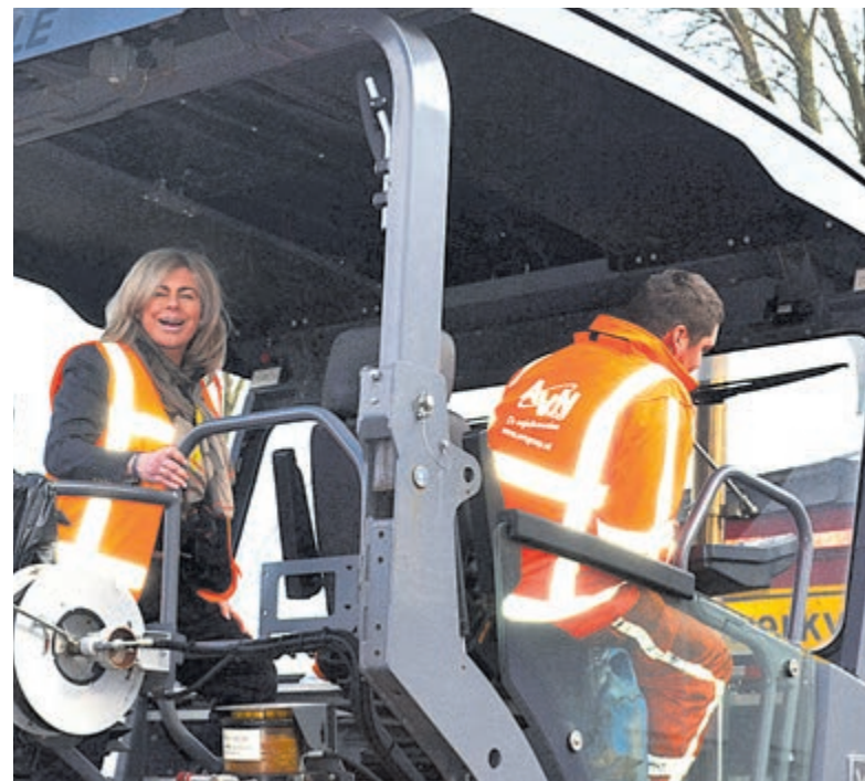
Wethouder Eveline Stam in de asfaltmachine. Foto: Bart Jonker.
