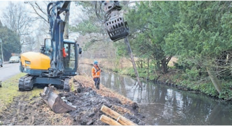
Werkzaamheden beschoeiing Burgemeester Van Doornkade. Foto aangeleverd door Gemeente Heemstede.
