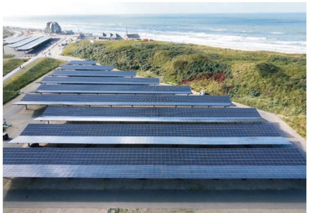
Een voorbeeld van zonnepanelen als overkapping van een parkeerterrein aan zee. Foto: Provincie Noord-Holland
