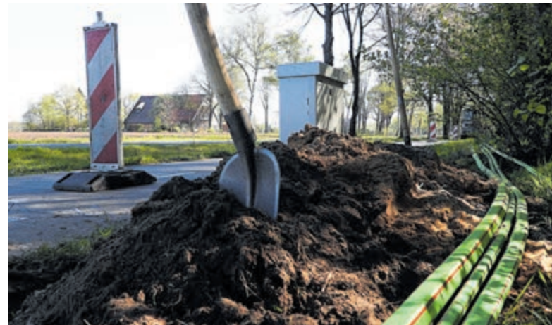
Aanleg glasvezel. Foto aangeleverd door DELTA Fiber Netwerk.
