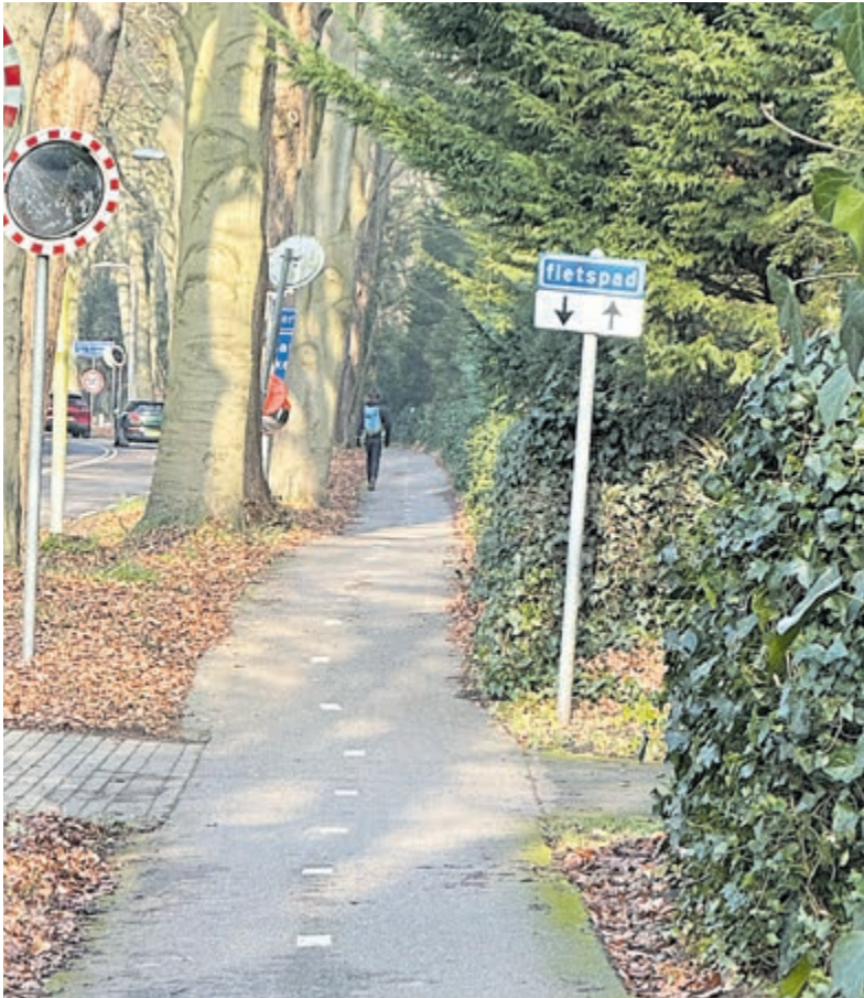
Het fietspad is smal en laat geen ruimte voor de wandelaar.
